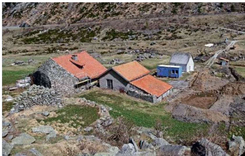
Alp Sogn Gagl, Val Medel, April 2020: Das Alpegebäude/Hospiz mit Stall und Kapelle während der Renovierung.
